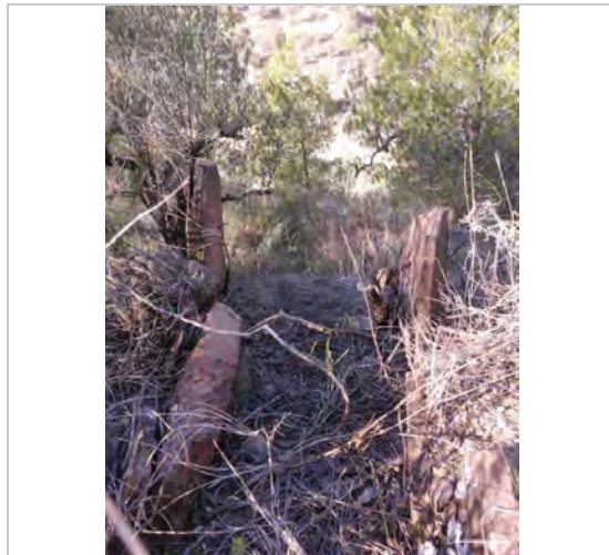
Canal d'aigua en un marge de pedra seca IRC
