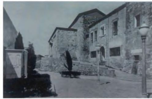
Foto de la zona abans de les obres (Font: BCMRO, 1994; imatge de 1945)
