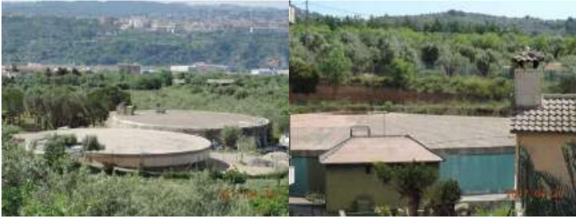
Foto 12 i 13. Vista dels dipòsits d'aigua on és impulsada l'aigua de les captacions del Mas de les aigües i que distribueixen per gravetat al nucli. L'altre dipòsit recull l'aigua del torrent d'Oromir.
