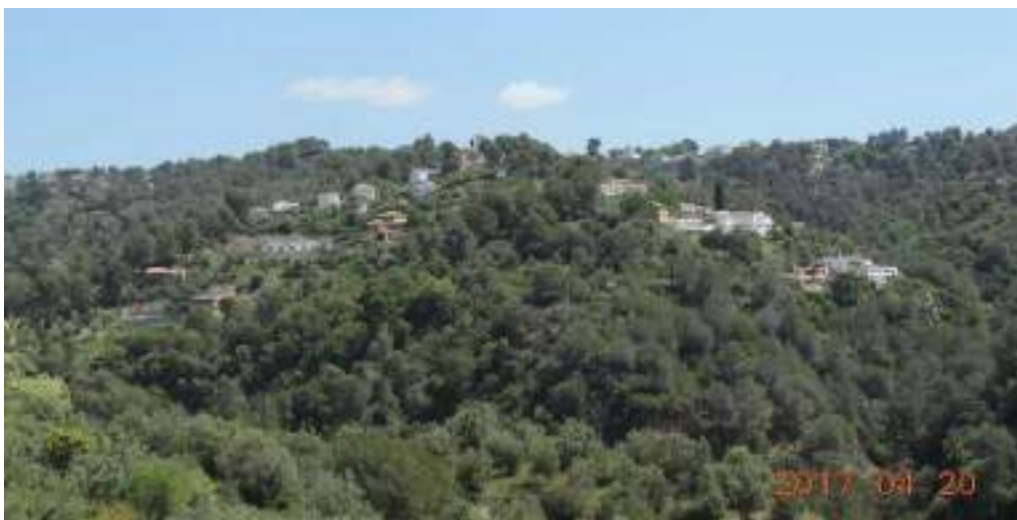
Foto 9. vista parcial de la urbanització Ribes Blaves ubicada enmig del sòl no urbanitzable en plena zona forestal.
